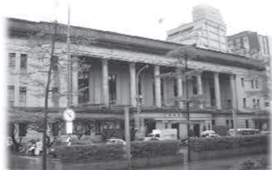
当時の舊の支店。今は使われる台湾銀行の建物の跡
