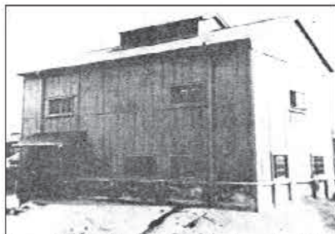
大黒三が人海無名の創業の途に不屈不休の努力で築き上げた帝人の工場。鈴木が破綻する寸前にフル稼働にこぎつける事ができた。
